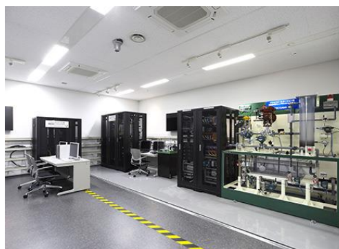
▲模擬プラント(手前:排水下水、奥:ビルオートメーション)
